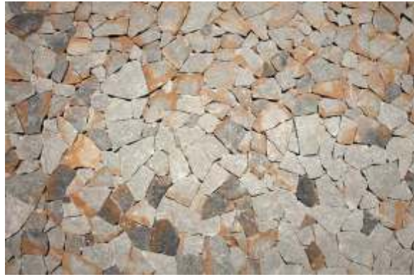
Muros exteriores de mampostería
