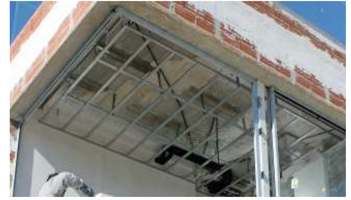
Detalle de los techos interiores
